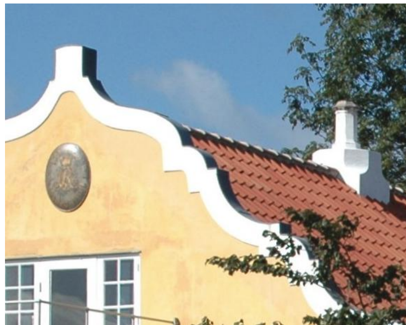
Toldkontrollørens hus. Sønder Land 28
